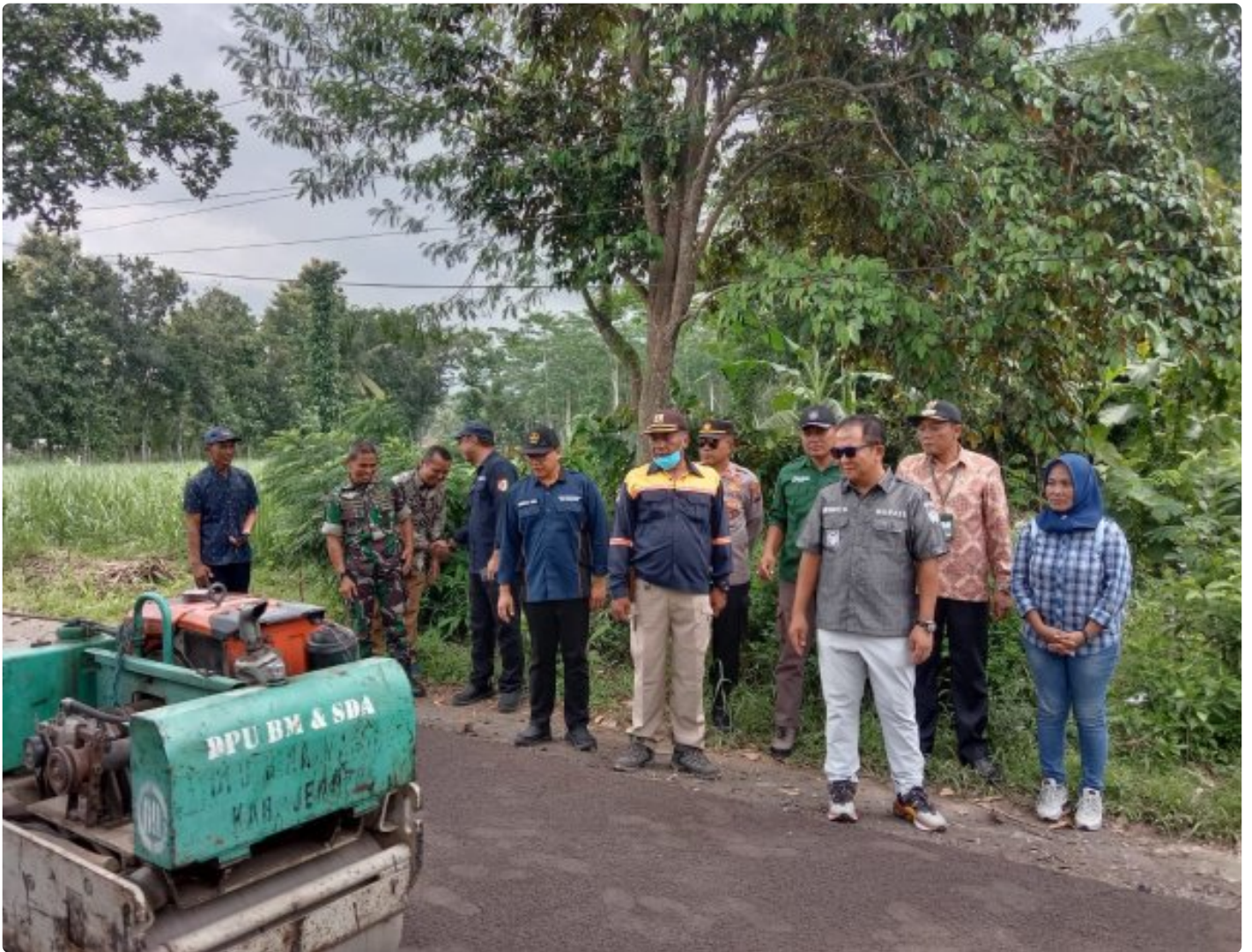
JEMBER – Pelaksanaan pengaspalan jalan desa yang menghubungkan antar Dusun Kebonsadeng dan Dusun Gayam Desa Kemuningsari Kidul Kecamatan Jenggawah Kabupaten Jember, dilakukan monitoring oleh Bupati Jember Hendy Siswanto.
